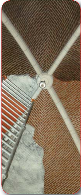
Reiniging van een bakstenen gewelf met BucoStar Peel-off super. Bovenaan: vóór de reiniging Onderaan links: tijdens Onderaan rechts: na de reiniging
