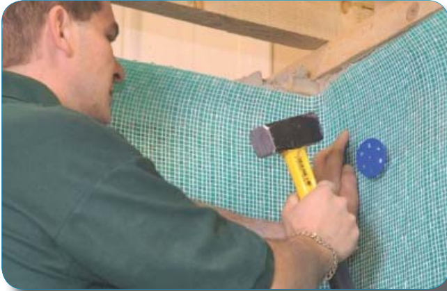
Hamer de pluggen in de ondergrond tot ze gelijk zitten met het membraan.
