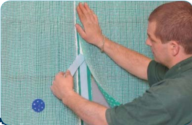
Overgangen tussen verschillende membranen worden afgedicht met Sealing tape of Sealing Kit.
